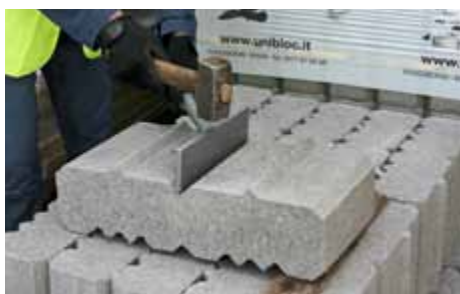
Operazione di spacco per ottenere due elementi per il montaggio singolo.
